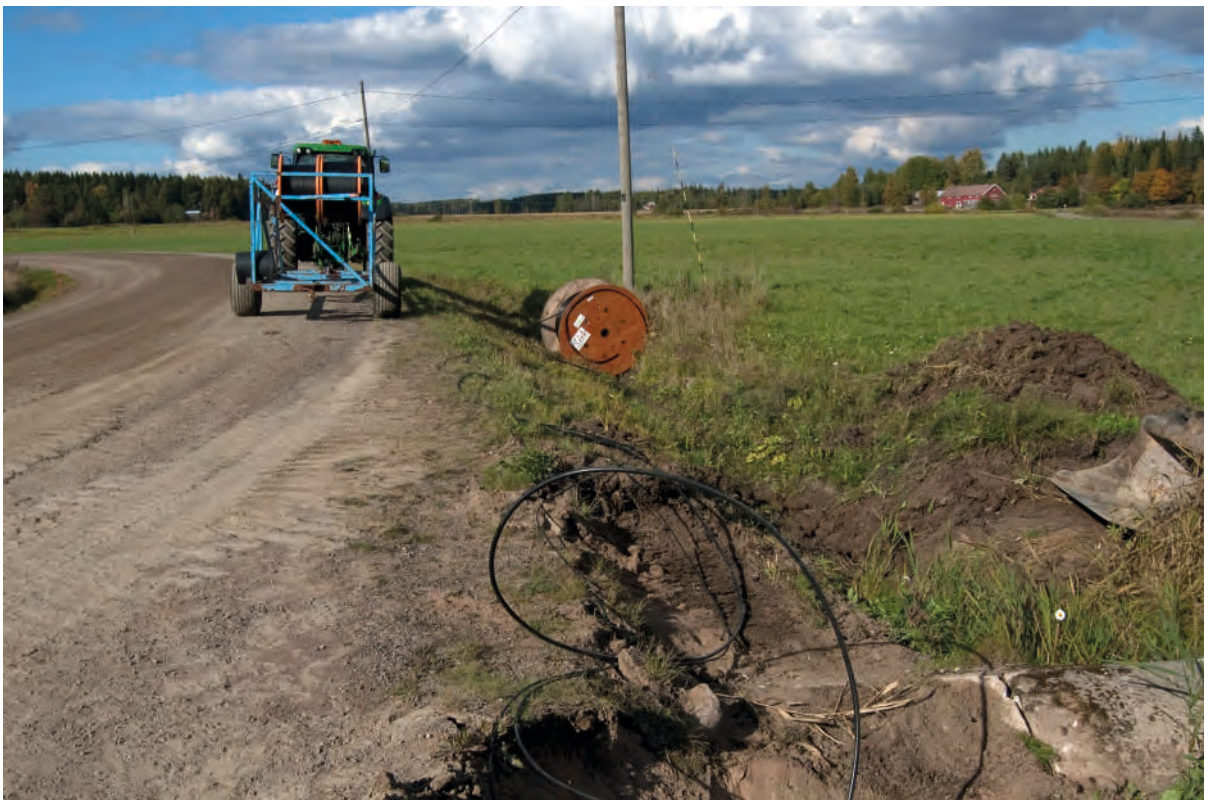
Valokuidun asennustyöt käynnissä.
